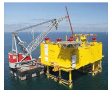
Umspannplattform für den Windpark SylWin1. Hier wird der in den Windkraftanlagen generierte Wechselstrom in Gleichstrom umgewandelt und verlustarm per Seekabel an Land transportiert
